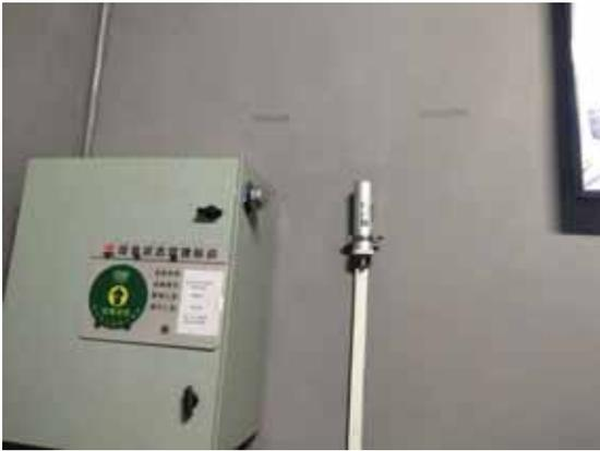
照片 7 固定式剂量监测仪探头
