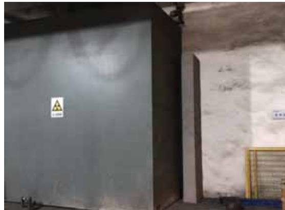
照片 4 工件防护门及南侧建墙垛
