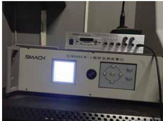
照片 10 固定式剂量监测仪显示屏
